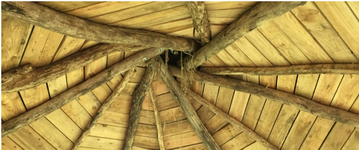
Het mooie dak van onze zelfgebouwde hut op Papschot
